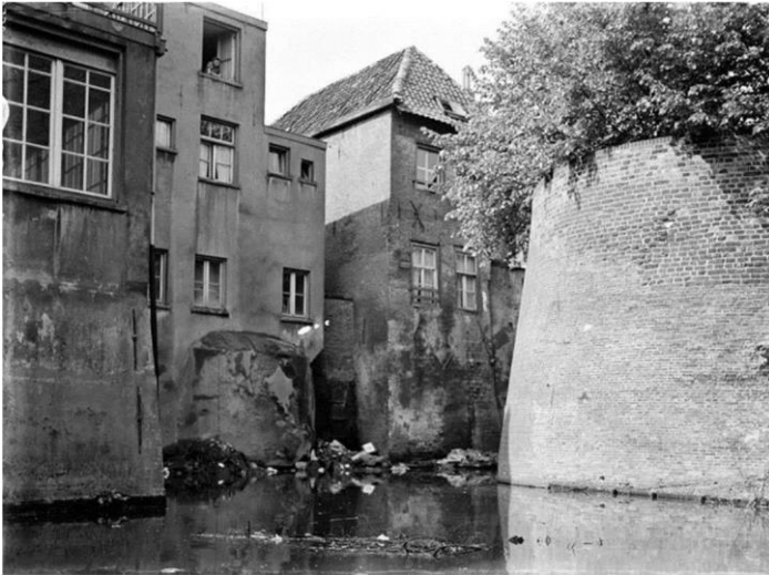
Figuur 4 De forse toren van de waterpoort vóór de demping van de Marktstroom
