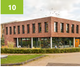
DE JACOBSVLINDER ■ Schoutenhoek 160 ■ DKV - Paul de Vroom Architecten ■ 2013
