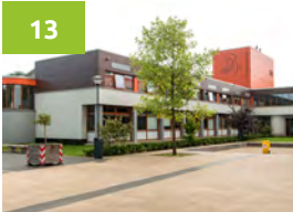
ERASMUSCOLLEGE ■ Van Doornenplantsoen 31 ■ Van den Broek en Bakema, projectarchitect G. Lans ■ 1972-1976 en Ralph Goutier ■ Gemeente Zoetermeer ■ 2010
