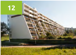
TERRASFLAT ■ Dumeelaan 246-575 ■ Leo de Jonge Architecten, projectarchitect T.Th.J. Remmers ■ 1984
